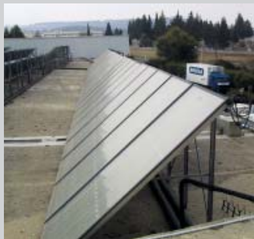
Εικ.2: Μια σειρά συλλεκτών του πεδίου ηλιακών της γαλακτοβιομηχανίας ΜΕΒΓΑΛ
