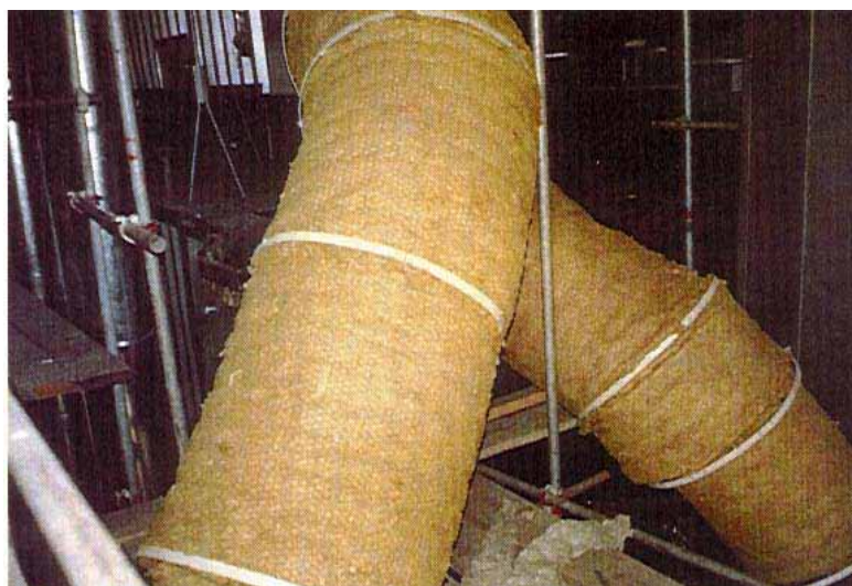
Σχήμα 5. Θερμομόνωση βιομηχανικών εγκαταστάσεων με χρήση ορυκτοβάμβακα
