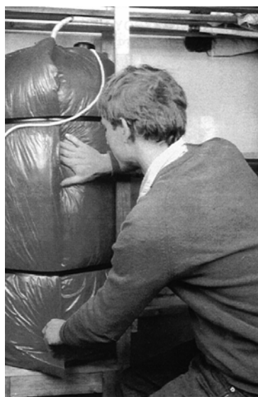
Σχήμα 7. Εργασίες θερμομόνωσης λεβητοστασίου
