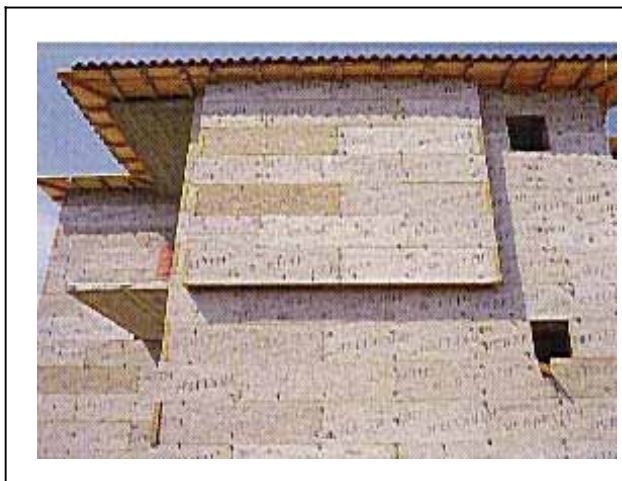
Σχήμα Β.2.1 Φωτογραφική παρουσίαση ολικής εξωτερικής θερμομόνωσης
