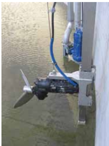
Σχήμα 7.22: Αναδευτήρας έλικας με καταδύόμενο μοτέρ (AGRINZ 2006)
