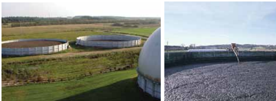
Σχήμα 7.32: Δεξαμενές αποθήκευσης με φυσικό επιπλέον στρώμα (DANISH BIOGAS ASSOCIATION 2008)
