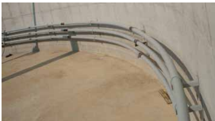
Σχήμα 7.17: Σωληνώσεις θέρμανσης εγκατεστημένες στο χωνευτή (AGRINZ 2008)
