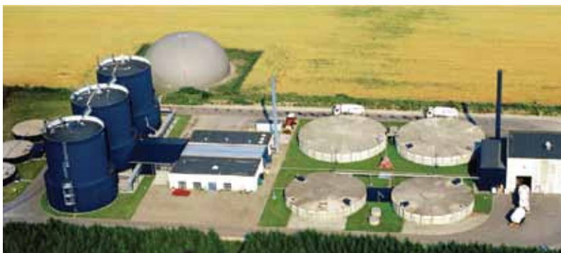
Σχήμα 4.8: Μονάδα συγχώνευσης στη Δανία (LEMVIG BIOGAS)
