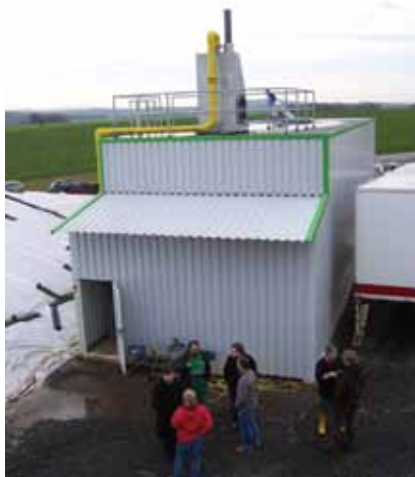
Σχήμα 7.21: Οριζόντιος χωνευτής στρωτής ροής (RUTZ 2006)
