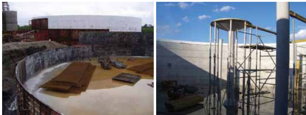
Σχήμα 7.19: Επιτόπου κατασκευή κατακόρυφων χωνευτών από σκυρόδεμα (RUTZ 2007)
