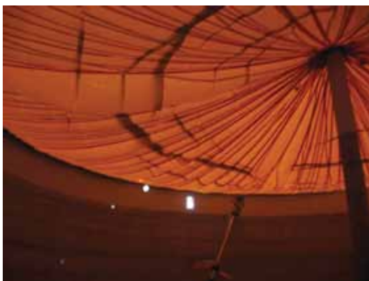
Σχήμα 7.27: Κάλυμμα χωνευτή από αεροστεγή μεμβράνη, όπως φαίνεται από το εσωτερικό της δεξαμενής - αριστερά (AGRINZ 2006), εφοδιασμένο εξωτερικά με πλέγμα διαστολής - δεξιά (RUTZ 2006)
