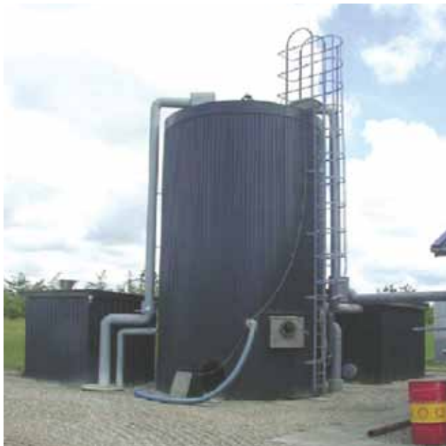
Σχήμα 7.31 Αντιδραστήρας για την αφαίρεση του υδρόθειου (ANGELIDAKI 2004)
