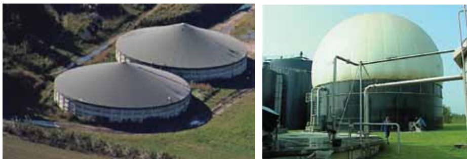
Σχήμα 7.33: Δεξαμενές αποθήκευσης καλυμμένες με μεμβράνες (DANISH BIOGAS ASSOCIATION 2008)
