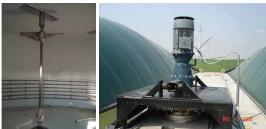
Σχήμα 7.23: Αναδευτήρες κρεμασμένων περυγίων (αριστερά) και η αντίστοιχη μηχανή ανάδευσης (δεξιά) (AGRINZ 2006)
