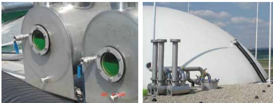
Σχήμα 7.25: Εγκαταστάσεις πίεσης και βαλβίδες ασφαλείας (AGRINZ 2006)
