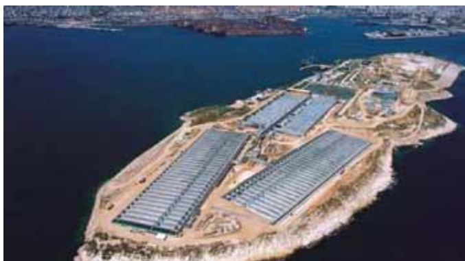
Σχήμα 4.11: Εγκατάσταση επεξεργασίας λυμάτων (ΕΕΑ) στην Ψυτάλλεια, Ελλάδα (ΕΥΔΑΠ Α.Ε.)
