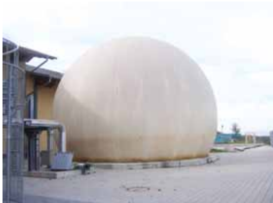
Σχήμα 7.26: Εξωτερικές δεξαμενές αποθήκευσης αερίου χαμηλής πίεσης (RUTZ 2007)
