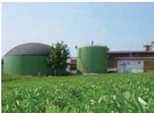
Σχήμα 4.6: Κατακόρυφος χωνευτής στη Γερμανία, που επεξεργάζεται στερεές κοπριές από χοίρους, πουλερικά και χορτονομές (KRIEG & FISHER 2008)
