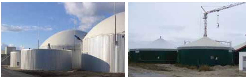
Σχήμα 7.20: Κατακόρυφοι χωνευτές καλυμμένοι από αεροστεγείς μεμβράνες. Η μεμβράνη διογκώνεται από το παραγόμενο βιοαέριο - αριστερά (AGRINZ 2008). Η μεμβράνη είναι στερεωμένη σε έναν κεντρικό ιστό - δεξιά (RUTZ 2006)
