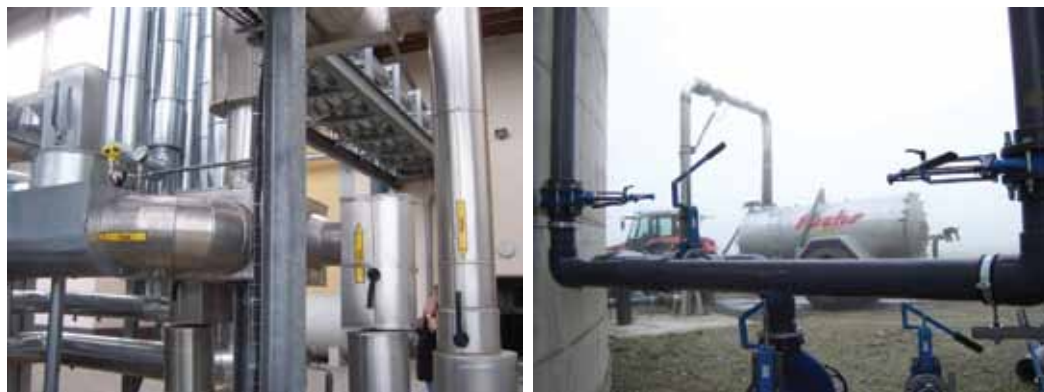
Σχήμα 7.15: Μονωμένες σωληνώσεις αερίου (αριστερά) και σωληνώσεις για το χωνεμένο υπόλειμμα (δεξιά) (RUTZ 2008)
