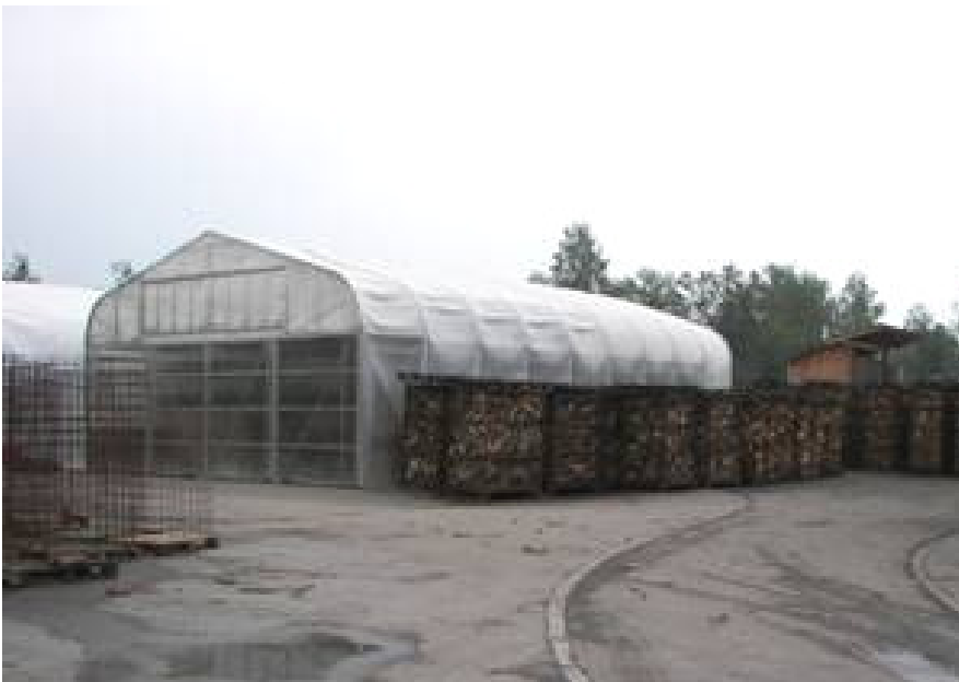
Σχήμα 4.9.3 Θερμοκήπια για την ξήρανση καυσόξυλων στο Biomassehof Allgäu (Βαυαρία, Γερμανία)
