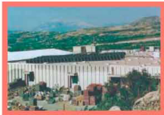
Σχήμα 4.13. Οι εγκατεστημένοι ηλιακοί συλλέκτες στο εργοστάσιο της Achaia Clauss
