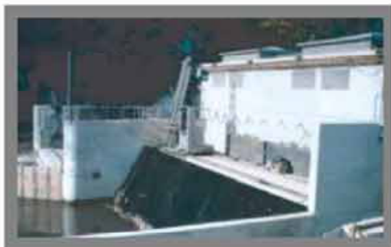
Σχήμα 6.5. Μηχανικό χτένι στο στόμιο εισόδου ενός μικρού υδροηλεκτρικού [Πηγή: Βιβλ., Μικρά Υδροηλεκτρικά, 1]
