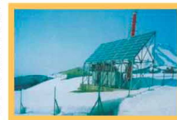
Σχήμα 5.7. Αυτόνομο φωτοβολταϊκό σύστημα τηλεπικοινωνιών στο όρος Δίρφη
