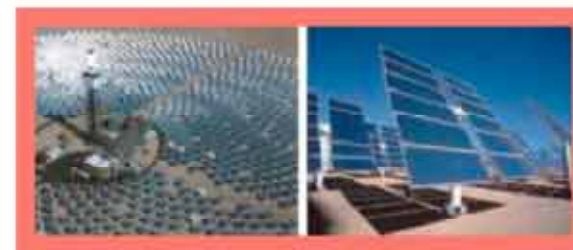
Σχήμα 4.9. Φωτογραφίες από το σταθμό ηλεκτροπαραγωγής πύργου ισχύος 10 MWe Solar Two
